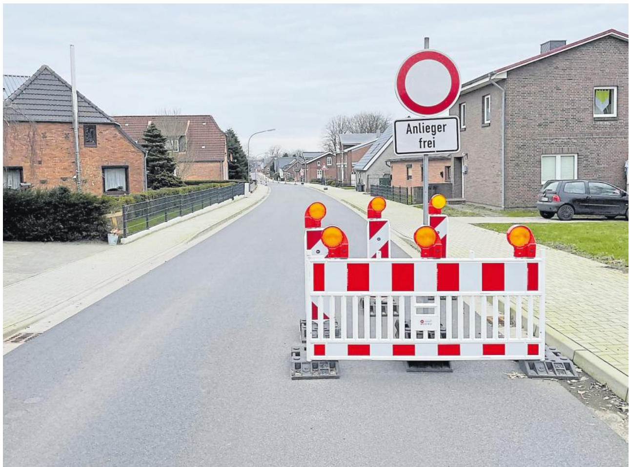
Die Ruhe vor dem Sturm: Die Hauptstraße in Eggstedt ist zwar gesperrt, aber noch wird dort nicht an der Fahrbahn gearbeitet. Das soll sich rasch ändern. Foto: Reh
