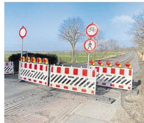
Zwischen Kleve und Schlichting wird derzeit die Landstraße 149 saniert.
