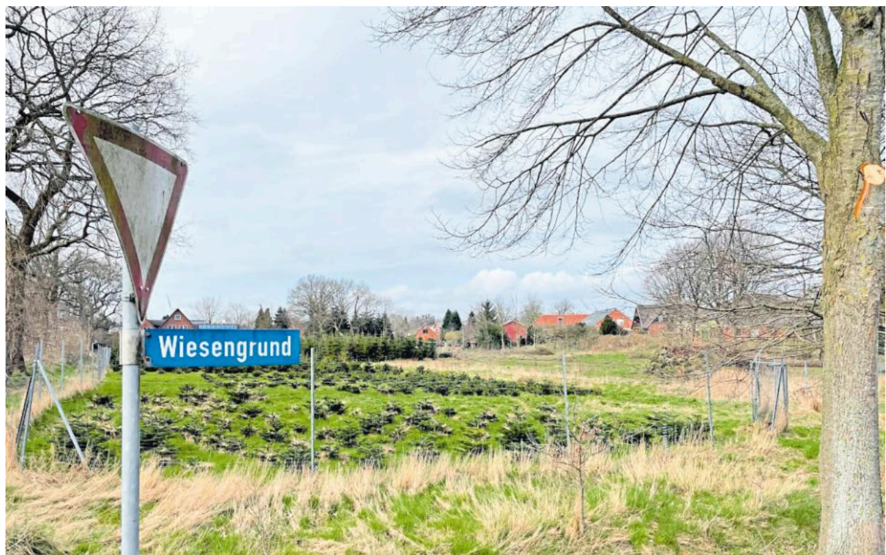
Wenn alles nach Plan läuft, sollen im April die ersten Baufahrzeuge anrollen: An der Süderstraße/Ecke Wiesengrund wird der neue Eggstedter Dorftreff errichtet.
